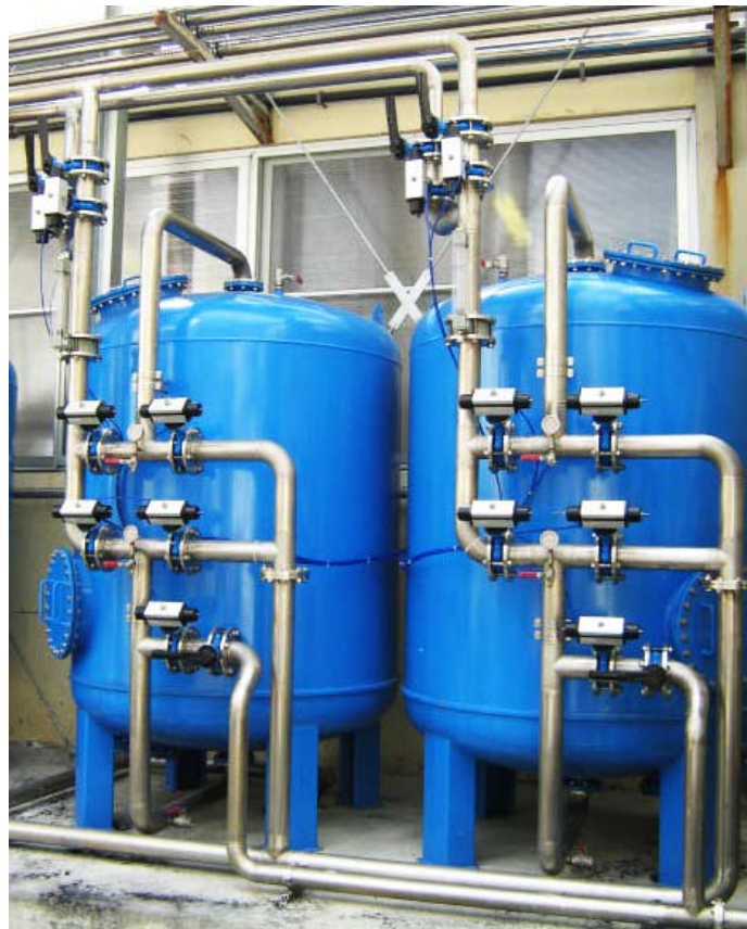
FILTRI A CARBONE IN PARALLELO FCST 1800 CON CROCIERA INOX 316
